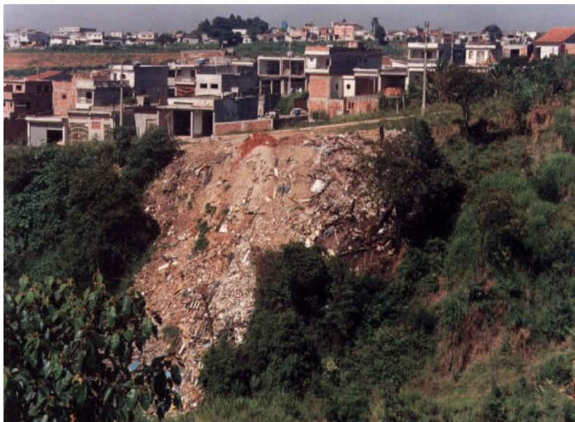
Figura 11 – Erosão de talude provocado por descarte irregular de RCC em São Paulo
