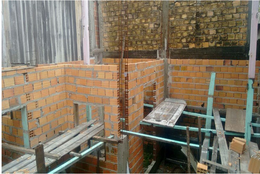
Figura 22 – Obra na fase de estrutura e fechamento em alvenaria – GERADOR 01
