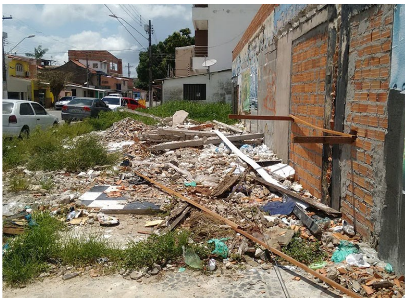
Figura 24 – Descarte em via pública por falta de local apropriado na obra – (GERADOR 02)
