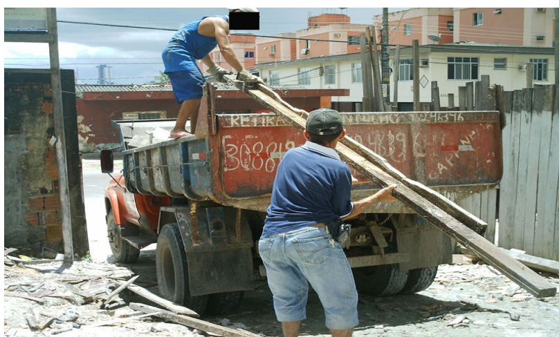
Figura 10 – Transporte de RCC realizado por caçambeiro
